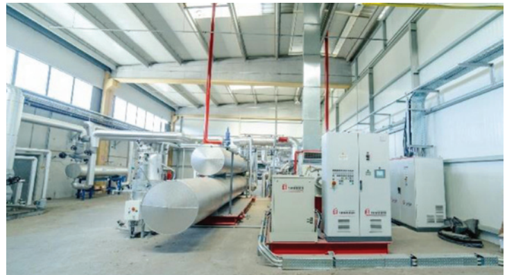
Εικόνες 1 & 2: Μονάδα παραγωγής ηλεκτρικής ενέργειας 1MWel της εταιρείας ΦΙΛΙΠΠΟΠΟΥΛΟΣ ΕΝΕΡΓΕΙΑΚΗ ΑΤΕ τεχνολογίας ORC Turboden στο εργοστάσιο παραγωγής στερεών βιοκαυσίμων (wood pellet και μπρικέτας) της ALFA WOOD ΝΕΥΡΟΚΟΠΙ ΑΕΒΕ
