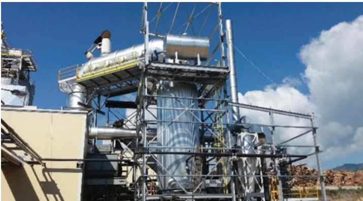
Εικόνες 1 & 2: Μονάδα παραγωγής ηλεκτρικής ενέργειας 1MWel της εταιρείας ΦΙΛΙΠΠΟΠΟΥΛΟΣ ΕΝΕΡΓΕΙΑΚΗ ΑΤΕ τεχνολογίας ORC Turboden στο εργοστάσιο παραγωγής στερεών βιοκαυσίμων (wood pellet και μπρικέτας) της ALFA WOOD ΝΕΥΡΟΚΟΠΙ ΑΕΒΕ
